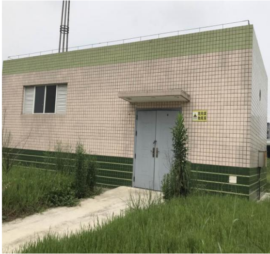
危险废物库房
